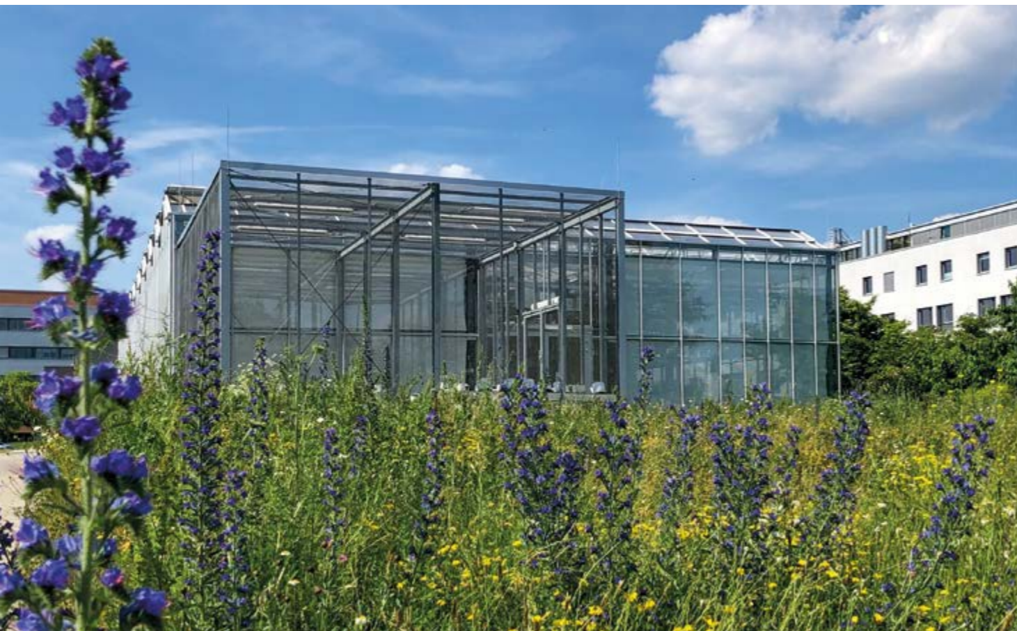
Abb. 33: Pflanzenforschungsanlage, Campusbereich Seltersberg der Justus-Liebig-Universität Gießen.
